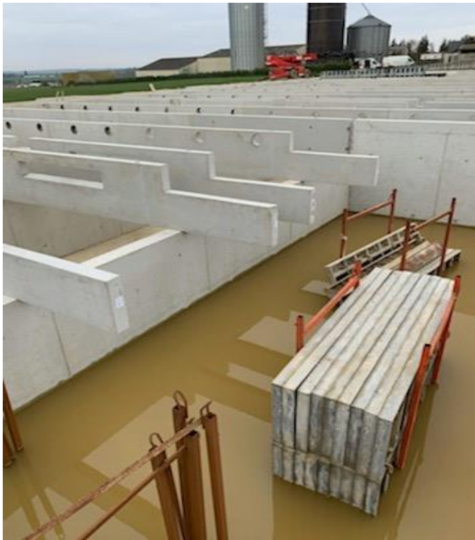
Photo RB Maçonnerie -chantier ST Barnabé
