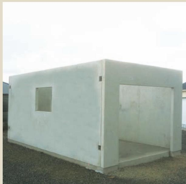
*Garage en clavetage mécanique*
