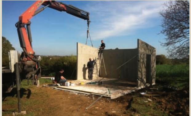
Exemple de réalisation d'un garage en préfa.
