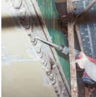
Réparation d'une allège de balcon: préparation du support
