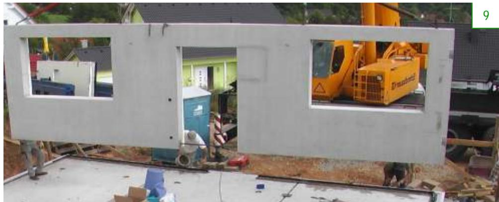
Assemblage mur et dalle
