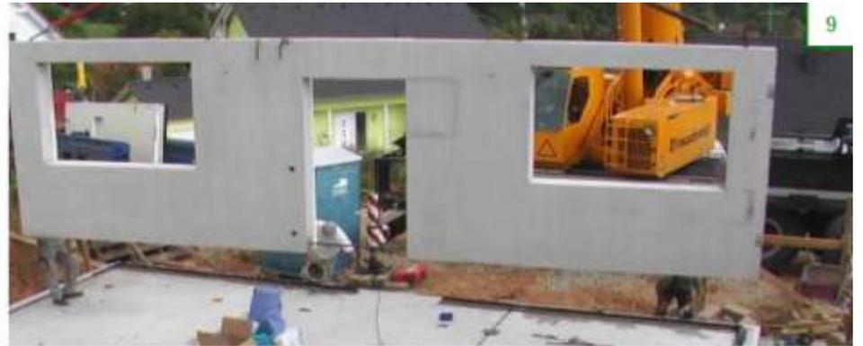
Assemblage mur et dalle
